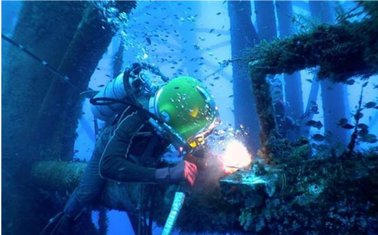
Slika 2. Moko podvodno zavarivanje [4]
