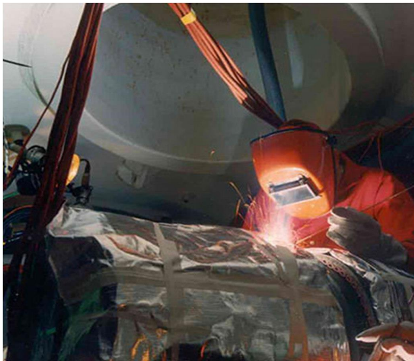
Slika 1. Suho podvodno zavarivanje [3]
