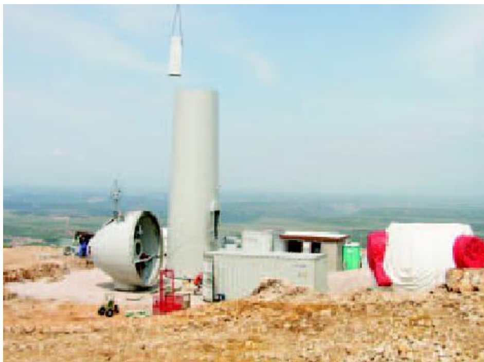
Slika 30. VE Trtar – Krtolin u izgradnji
