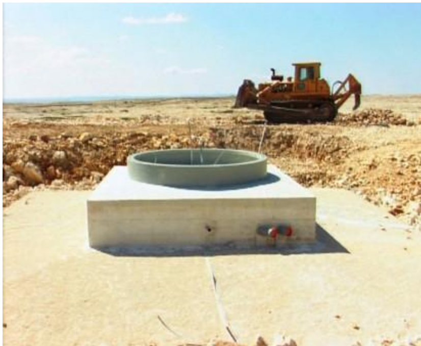
Slika 15. Izrada temelja za vjetrogenerator.
