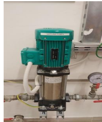
Slika 29. Elektro pumpe radna i rezervna (lijevo) te jockey pumpa-napojna (desno) [10]
