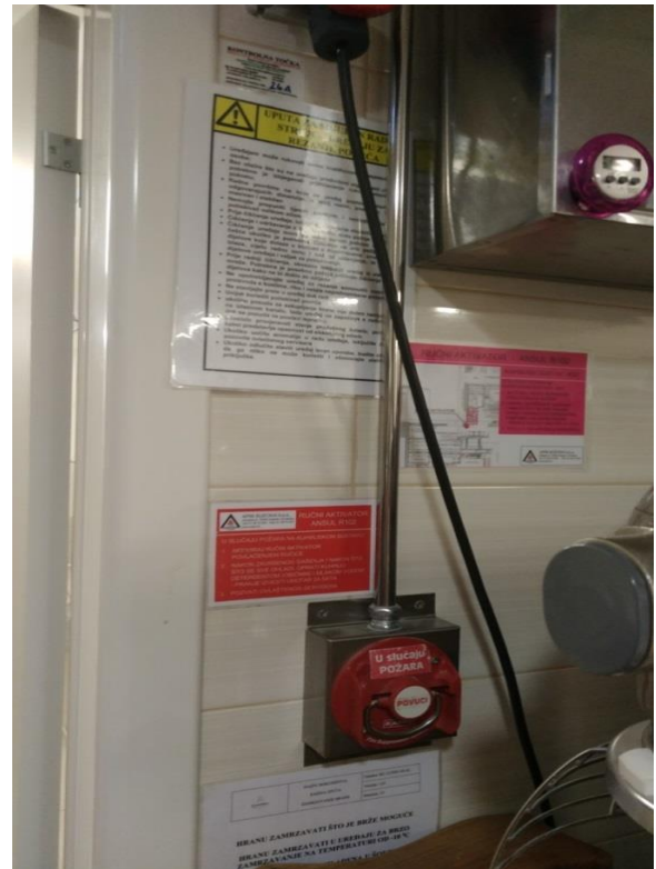
Slika 18. Prikaz kuhinjskog sustava za gašenje Ansul R-102 s uputama [10]
