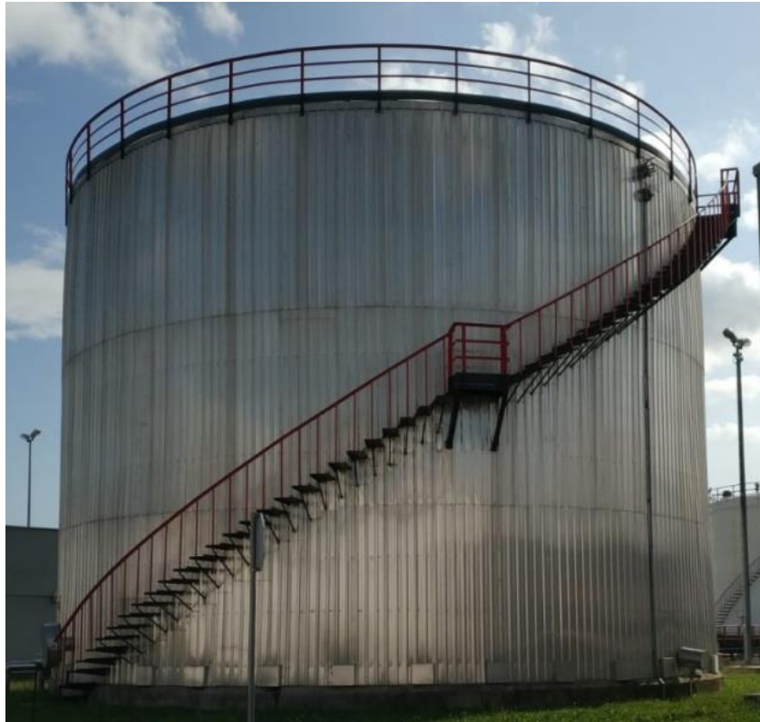
Sl. 7. Prikaz spremnika vode sa punjenjem iz bunara i hidrantske mreže [vlastita fotografija]
