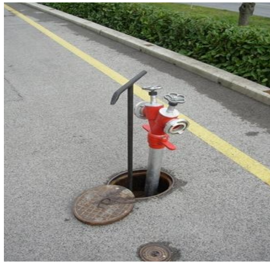
Slika 24. Hidrantski nastavak spojen na podzemni hidrant [18]
