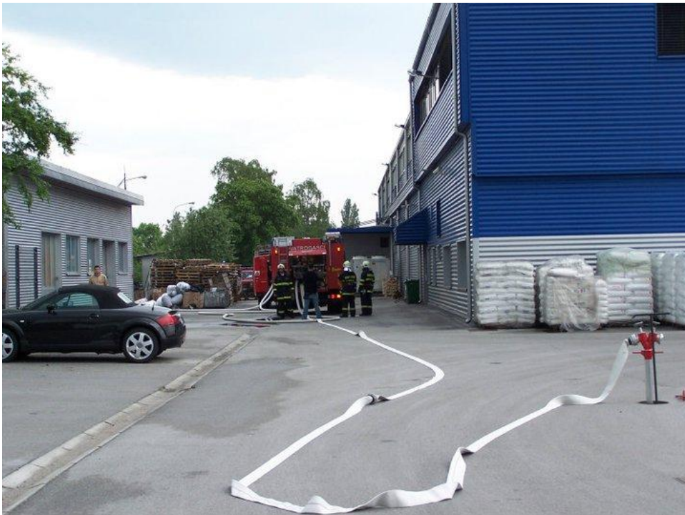
Slika 30. Uporaba podzemnog hidranta broj 4 za napajanje vatrogasnog vozila vodom [20]
