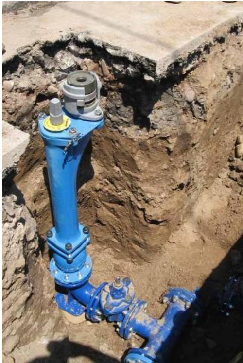
Slika 10. Podzemni hidrant [22]
