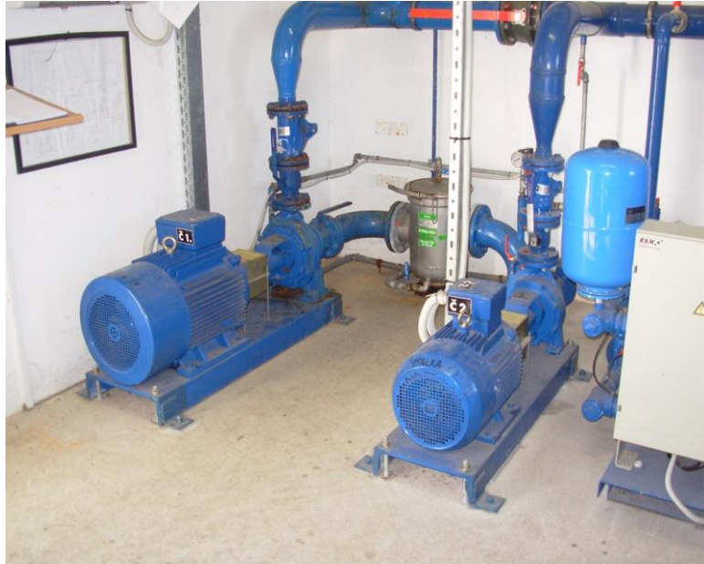
Slika 14. Prostorija sa uređajem za povišenje tlaka [18]
