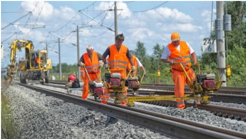
Slika 2: Radovi na pruzi
