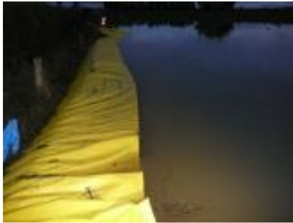
Slika 20. Vodeni kavez postavljen kako bi zaštitio naselje [6]
