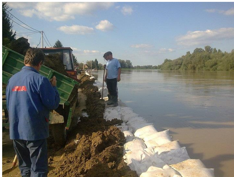
Slika 37. Rijeka Sava 20.09.2010. – izrada tzv. „zečjih nasipa“ [12]
