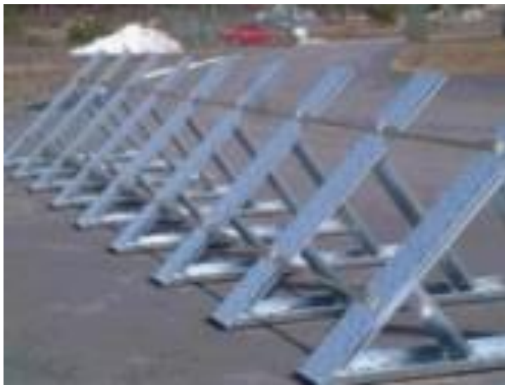
Slika 4. Nosači su spojeni pomoću vodoravnih profila [3]
