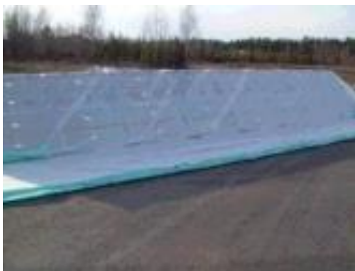
Slika 6. Platna prekrivaju prednji dio pregrade [3]
