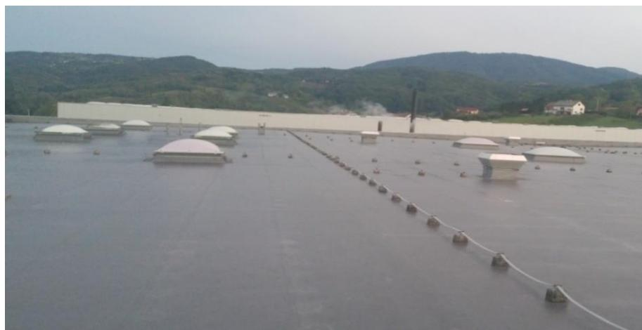
Slika 20. Sustav obrane od udara groma na krovu pogona
