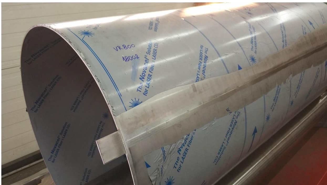
Slika 28. Priprema plašta za izradu uzdužnog zavora
