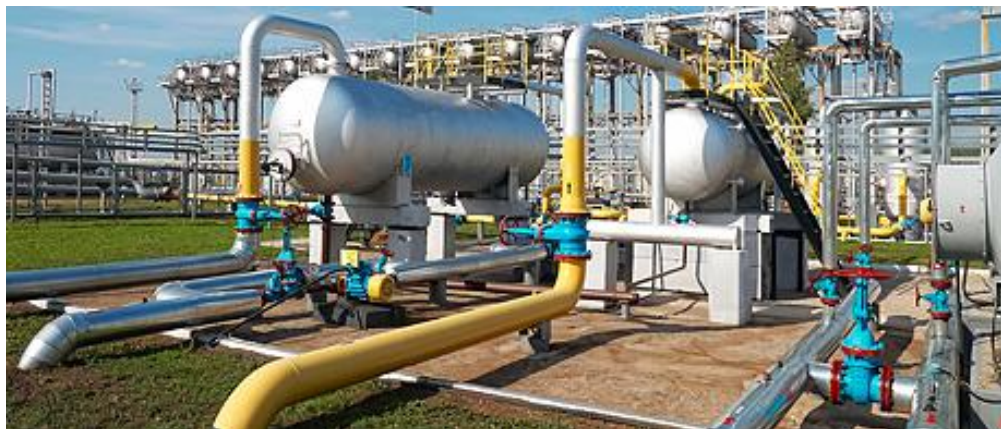
Slika 4. Primjer prikupljajućeg cjevovoda [5]
