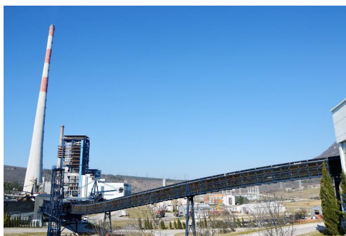
Slika 5. Traka kojom ugljen dolazi na deponij. [10]
