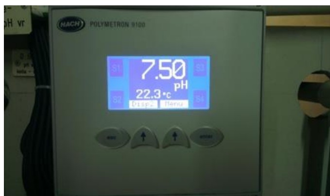
Slika 17. Pročišćena voda nakon pješčanih filtera.
