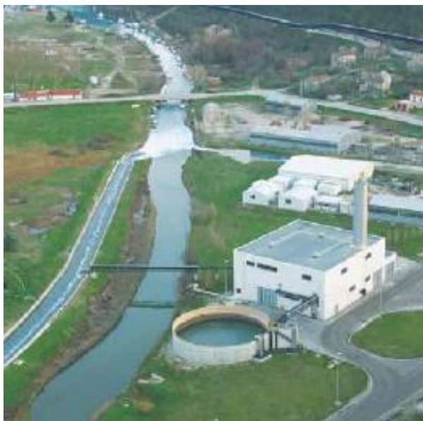
Slika 9. Postrojenje za obradu otpadnih voda. [13]
