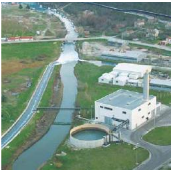
Slika 9. Postrojenje za obradu otpadnih voda. [13]
