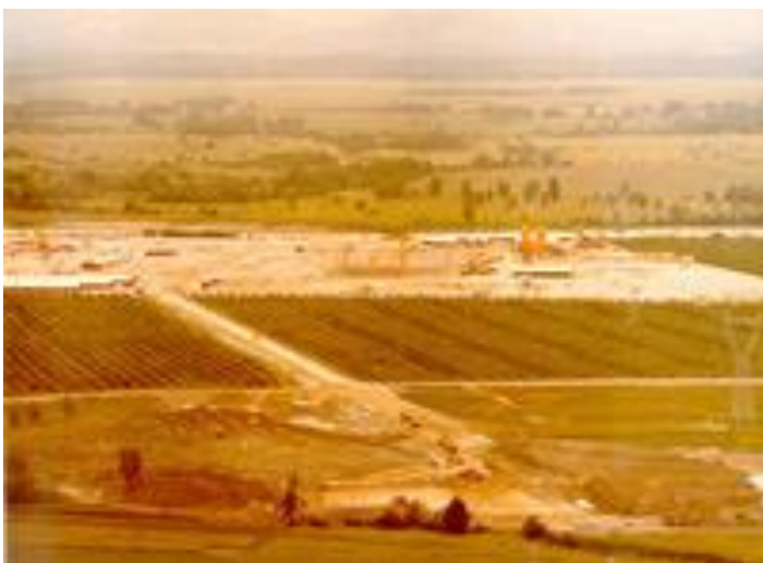
Slika 2. 1975. – početak iskopavanja i građevinskih radova na gradilištu
