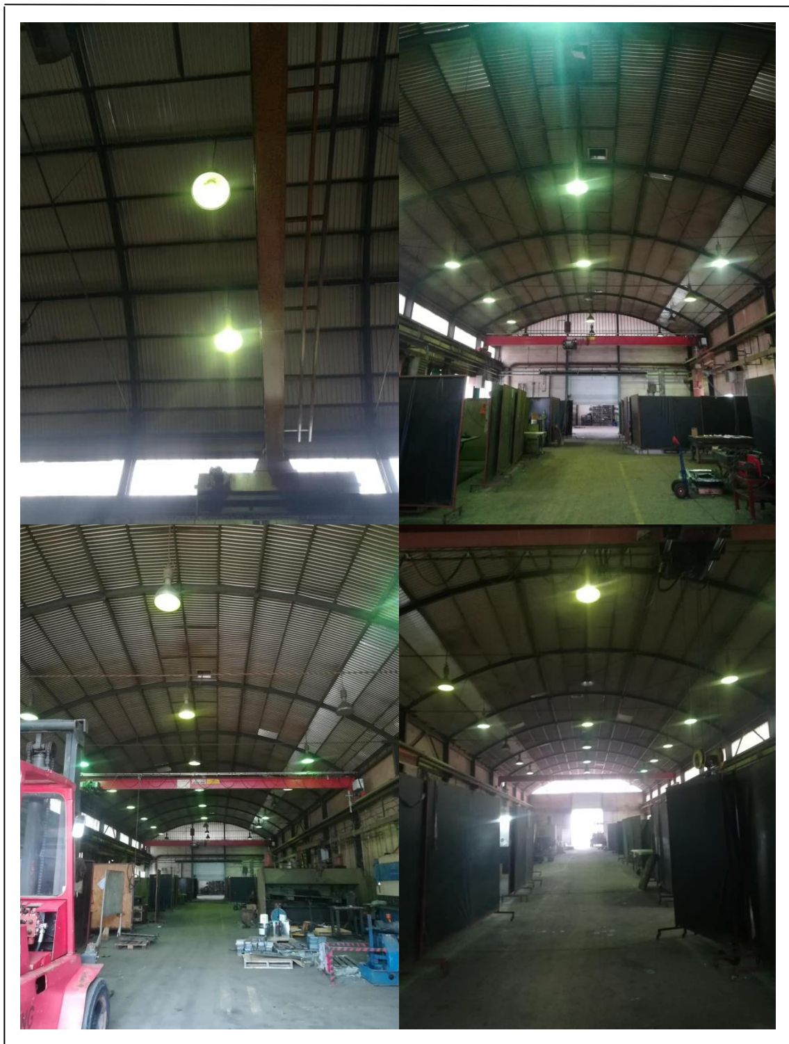
Slika 20: Pogon bravarsko-zavarivačkog rada
