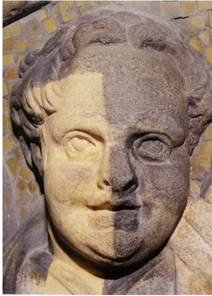
Slika 9: Lasersko čišćenje kamena [13]
