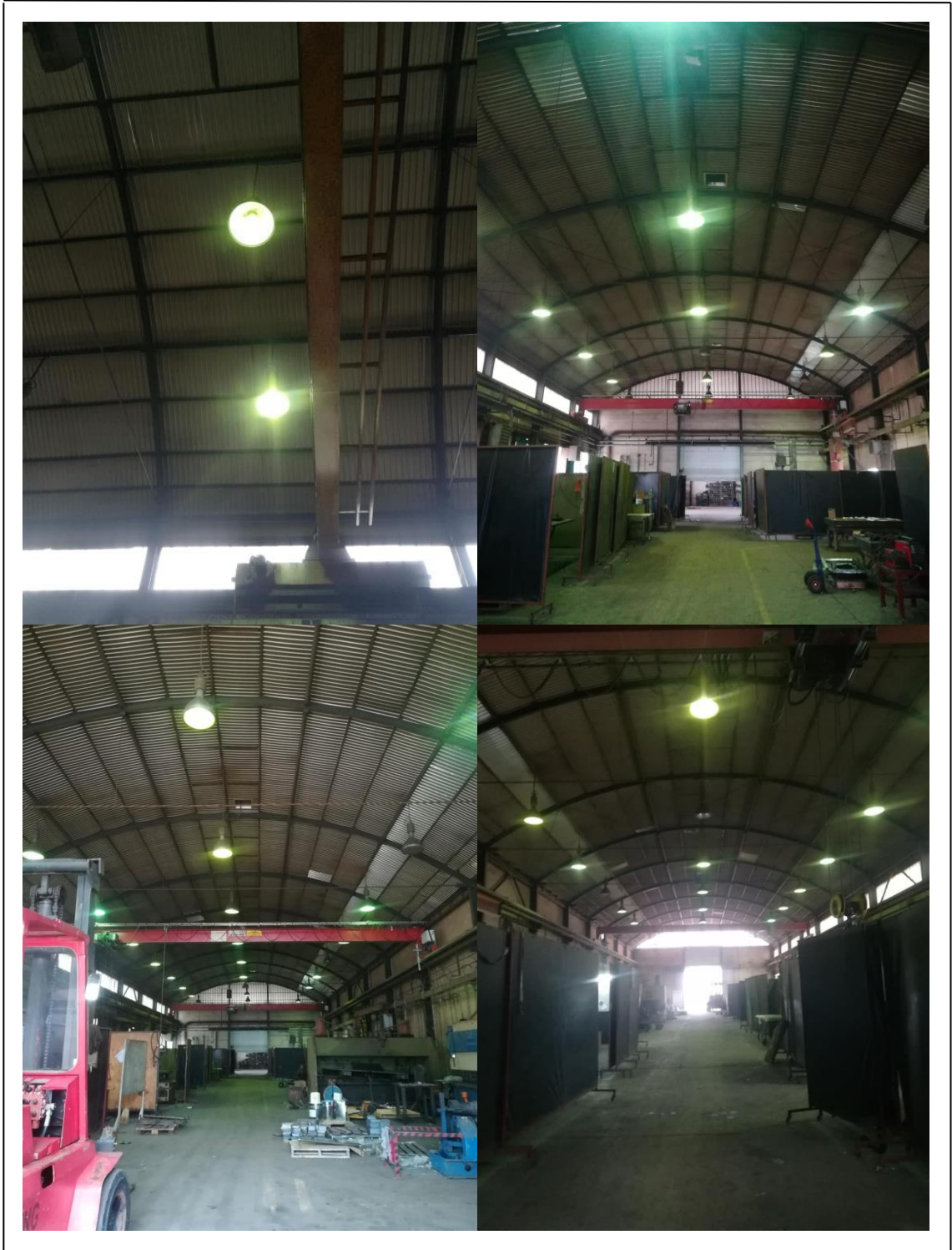
Slika 20: Pogon bravarsko-zavarivačkog rada
