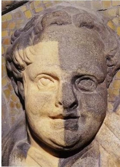
Slika 9: Lasersko čišćenje kamena [13]
