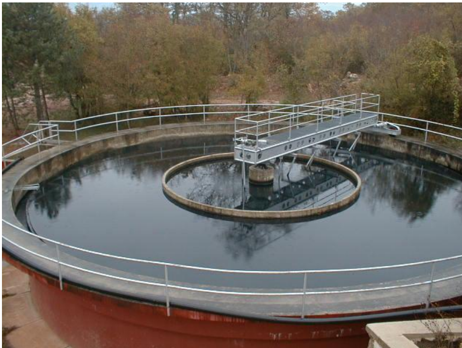
Slika 14. Bazen za flokulaciju
