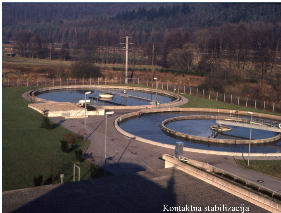
Slika 17. Bazeni za kontaktnu stabilizaciju
