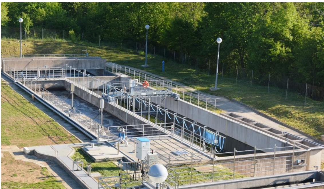
Slika 6. Uređaj za pročišćavanje otpadnih voda
