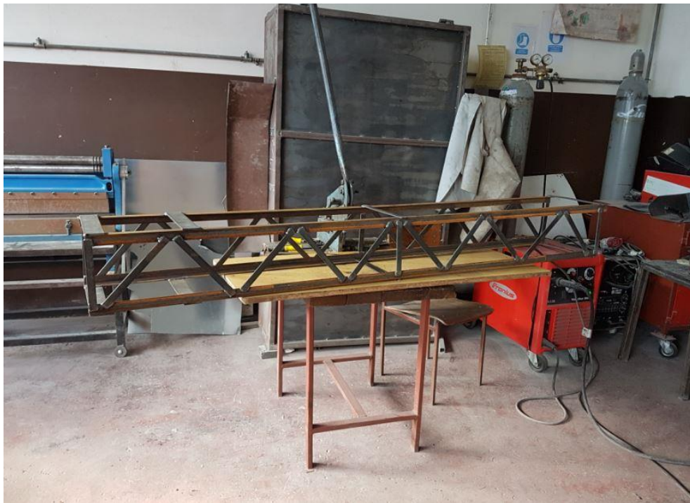
Slika 66.: Zavarivanje stranica konstrukcije
