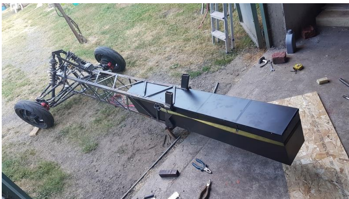
Slika 89.: Postupak uvlačenja baterije unutar konstrukcije
