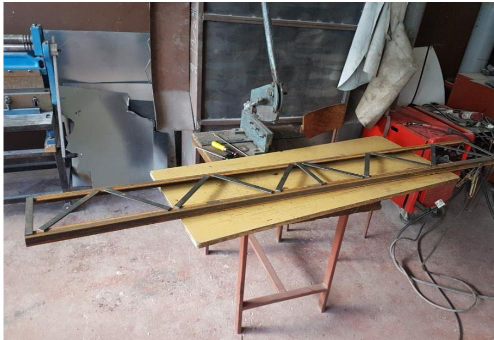
Slika 64.: Postavljanje rešetkastog nosača nosive konstrukcije
