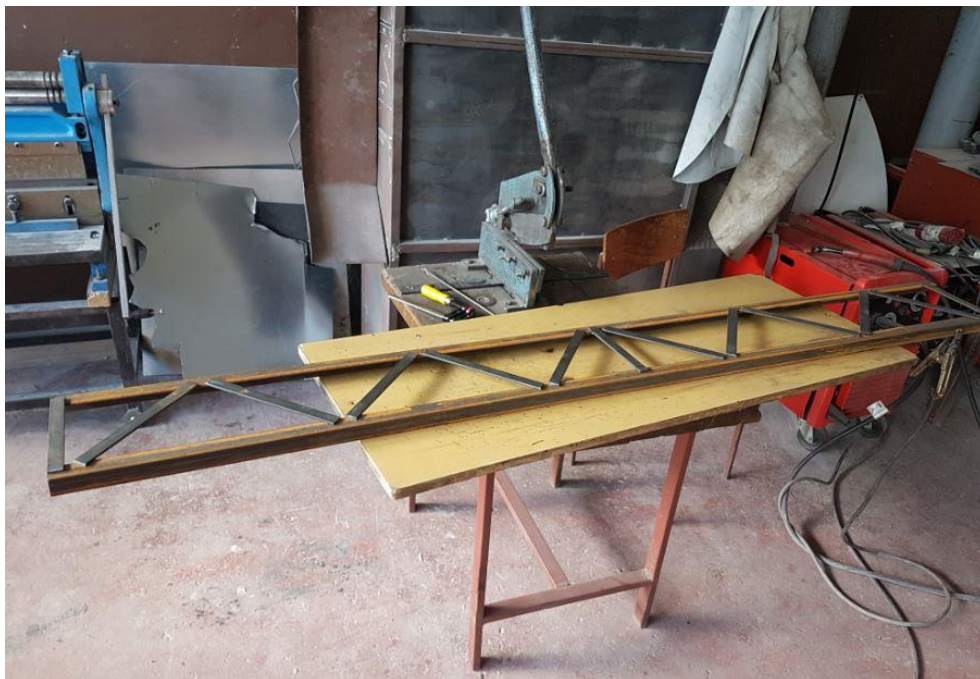
Slika 64.: Postavljanje rešetkastog nosača nosive konstrukcije
