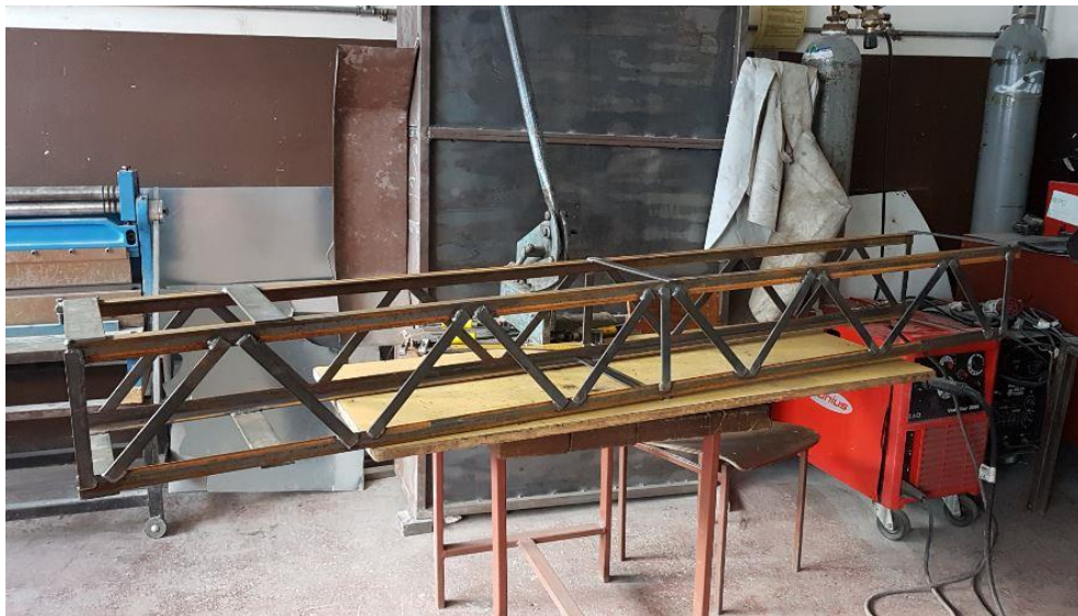
Slika 67.: Pregled zavarenih spojeva
