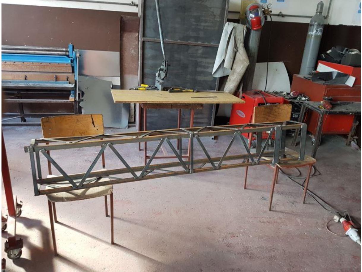
Slika 68.: Zavarivanje ostalih stranica konstrukcije
