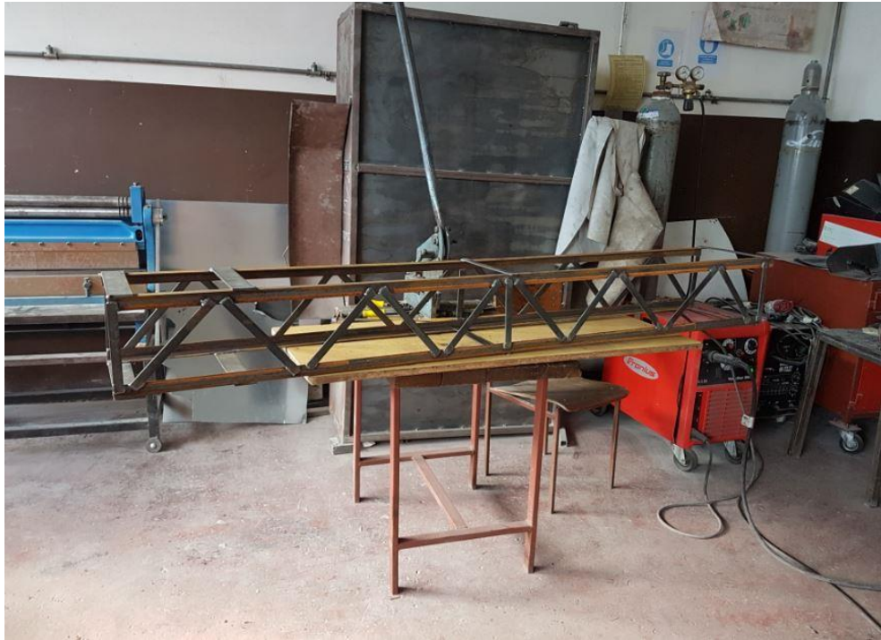
Slika 66.: Zavarivanje stranica konstrukcije
