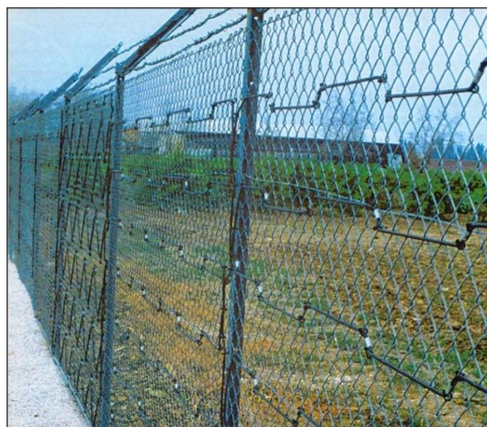
*Slika 7. Prikaz načina postavljanja senzorskog vodiča na ogradu*
