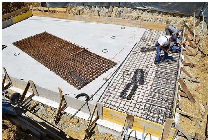
Slika 16. Ugradnja armature [27]
