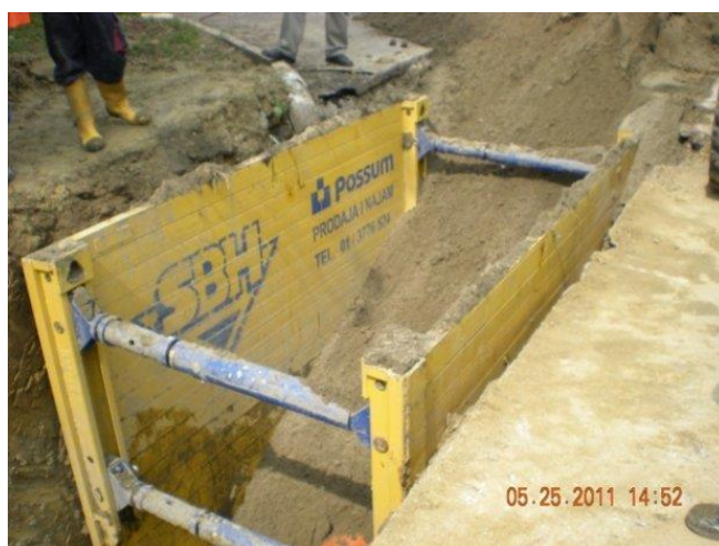
Slika 9. Zaštita bočnih strana prilikom iskop [19]
