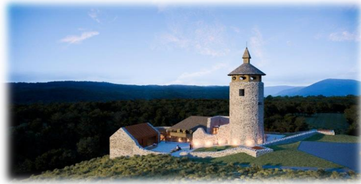
Slika 5. Stari grad Drežnik nakon renovacije
