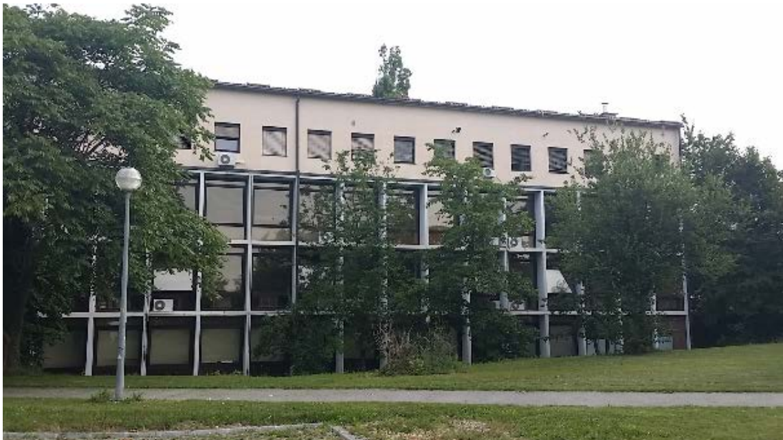
Slika 8. Zgrada Geofizičkog odsjeka
