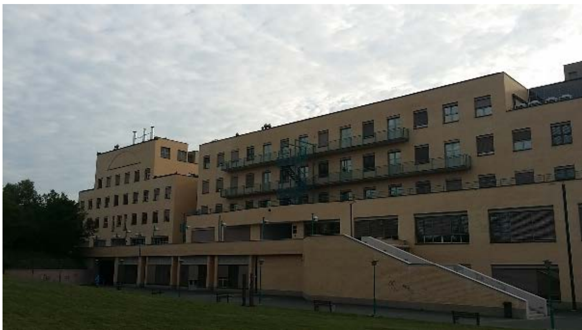
Slika 1. Zgrada Dekanata i Kemijskog odsjeka
