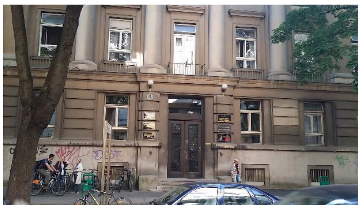
Slika 7. Zgrada Geografskog odsjeka
