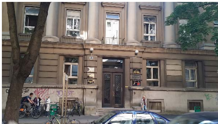
Slika 7. Zgrada Geografskog odsjeka
