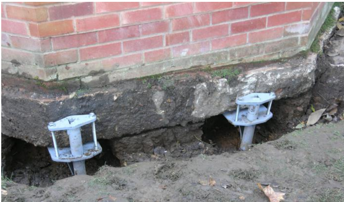
Slika 5. Čelični duboki piloti [11]
