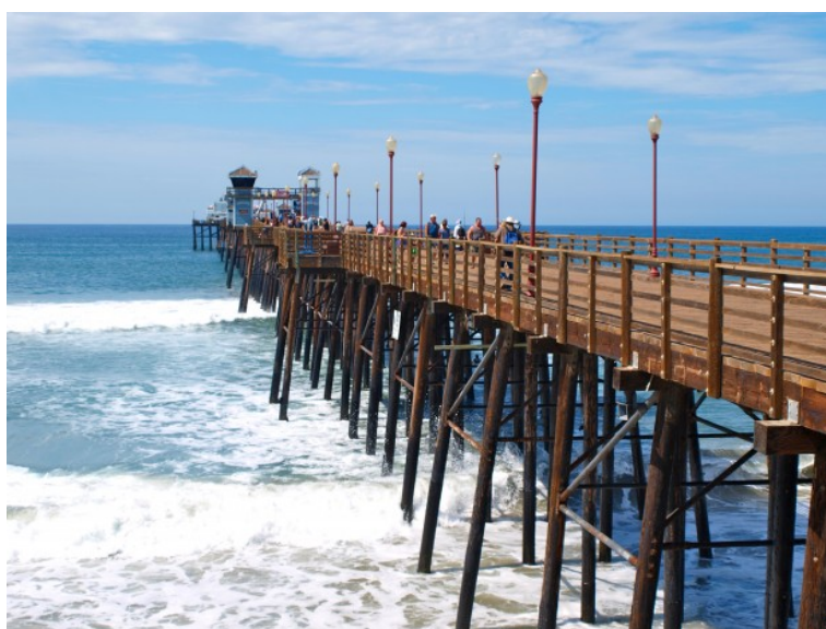
Slika 17. Drveni piloti postavljeni kao temelji [14]
