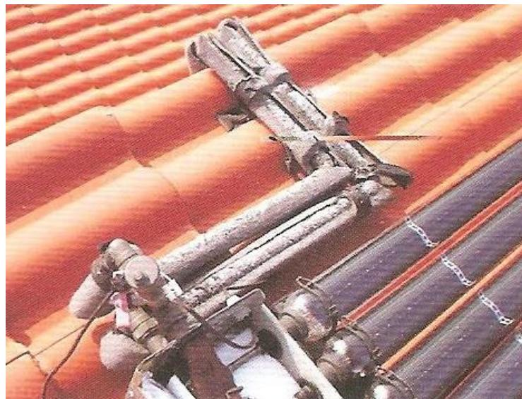
Slika 6.4. Izolirane cijevi običnom izolacijom [1]
