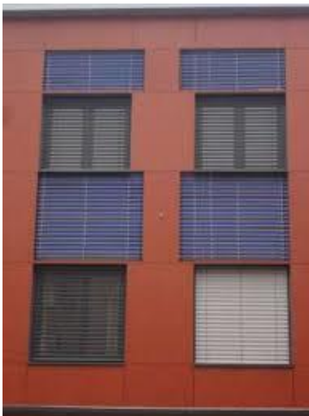
3.12. Vakuumski kolektori na fasadi objekta, Špansko – Zagreb [1]
