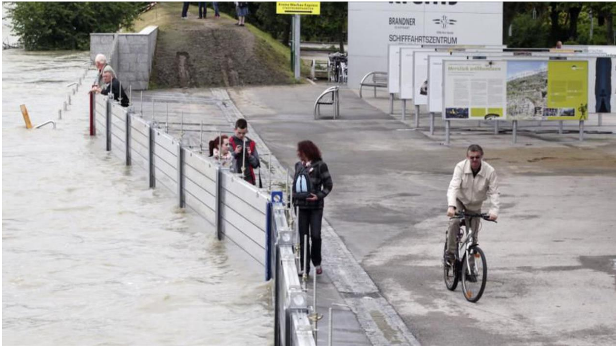
Slika 5 - Montažne brane u Austriji.[10]
