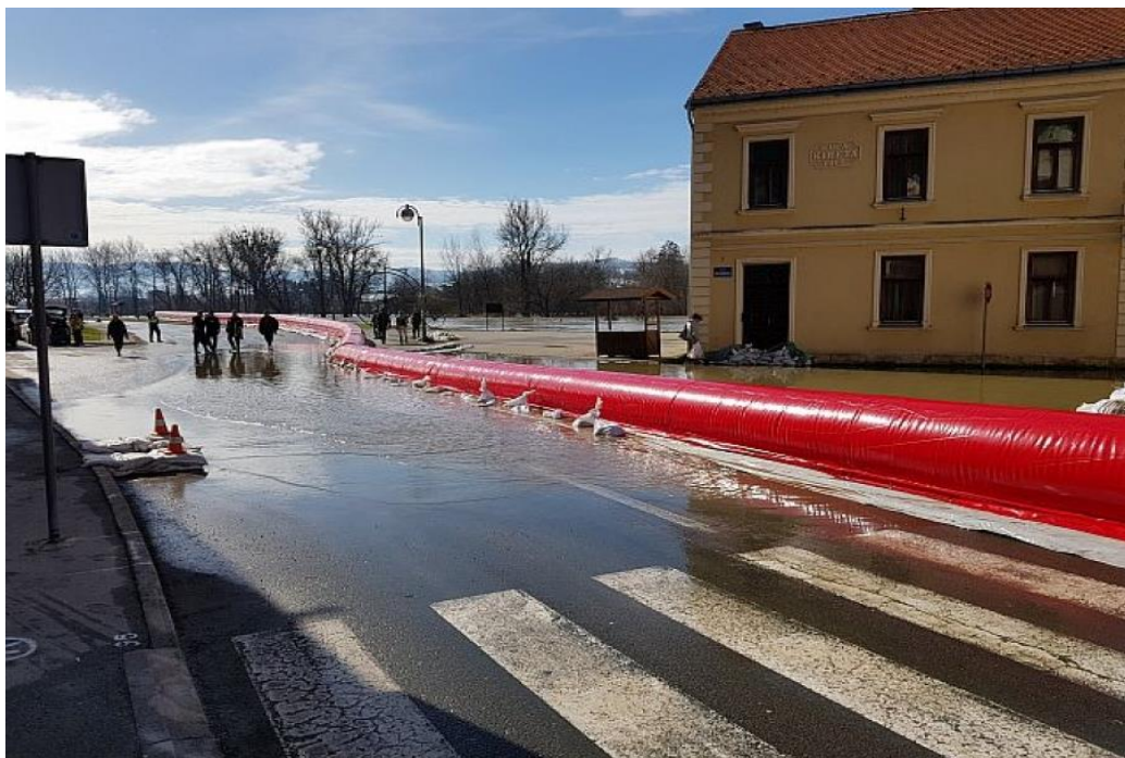
Slika 6 - Sustav vodom protiv vode.[11]
