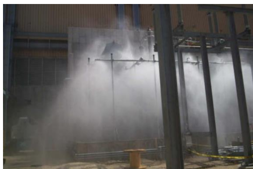
Slika 22. Aktivirani sustav za gašenje vodenom maglom [17]
