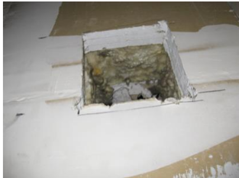
Slika 29. Požarni zid Trg. centra "Supernova" [14]
