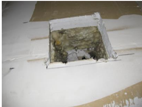
Slika 29. Požarni zid Trg. centra "Supernova" [14]
