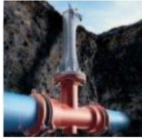
Slika 5. Podzemni hidrant.[8]
