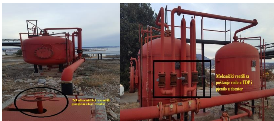
Sl. 14. Ručna aktivacija TDP-a
