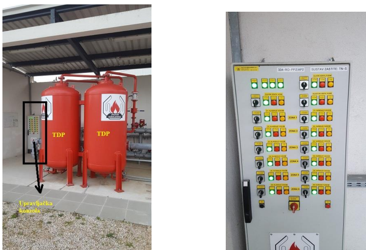
Sl. 13. Poluautomatska aktivacija drencher sustava
