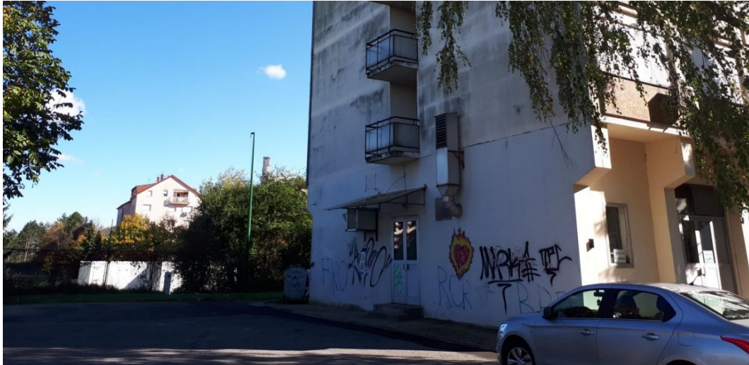
Slika 8. Sjeverna strana perimetra 1
