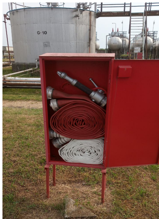
Slika 28. Prikaz hidrantskog ormarića [14]
