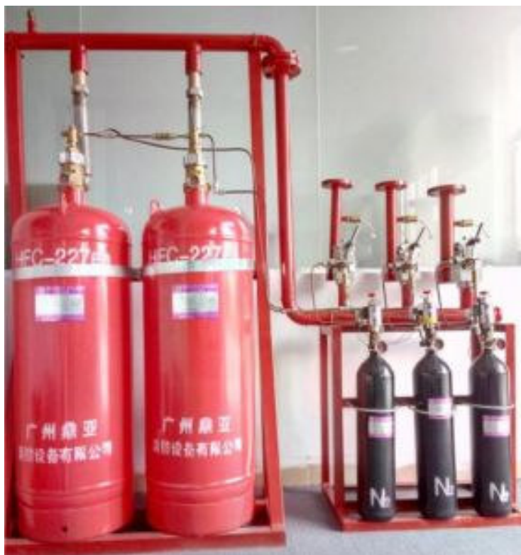
Slika 10 Primjer stabilnog sustava za gašenje požara FM 200, [15]
