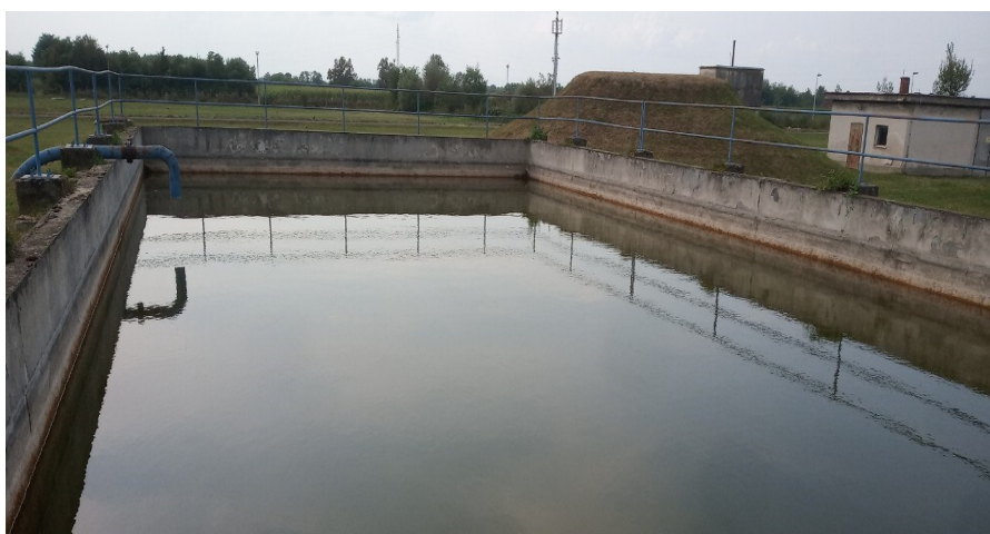
Slika 17 Primjer poluukopanog spremnika za vodu [14]
