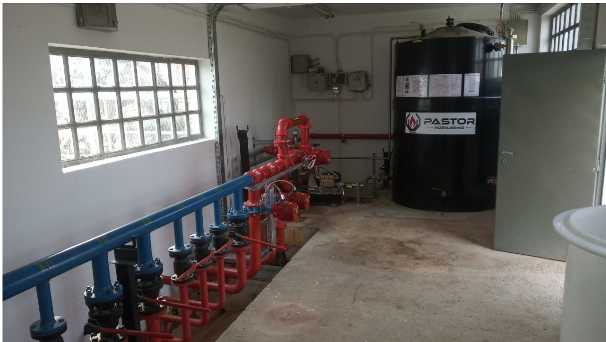
Slika 28 Prikaz sustava za gašenje TK 903, G 10-14 u vatrogasnici [14]
