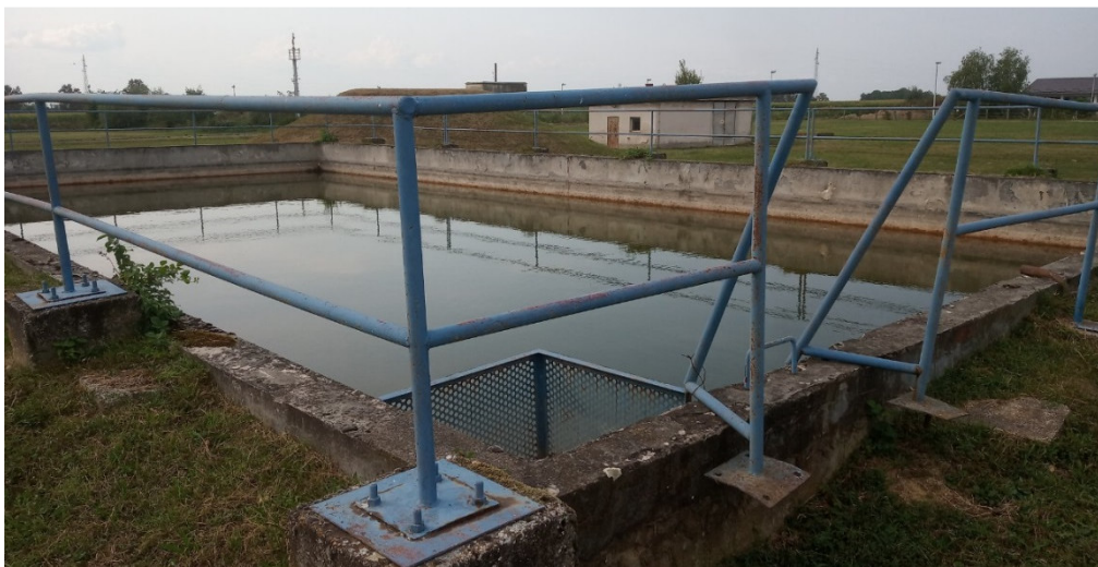
Slika 23 Prikaz poluukopanog spremnika za vodu [14]
