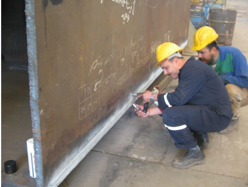
Slika 22. Izvođenje magnetske kontrole u radionici na zavaru [30]
