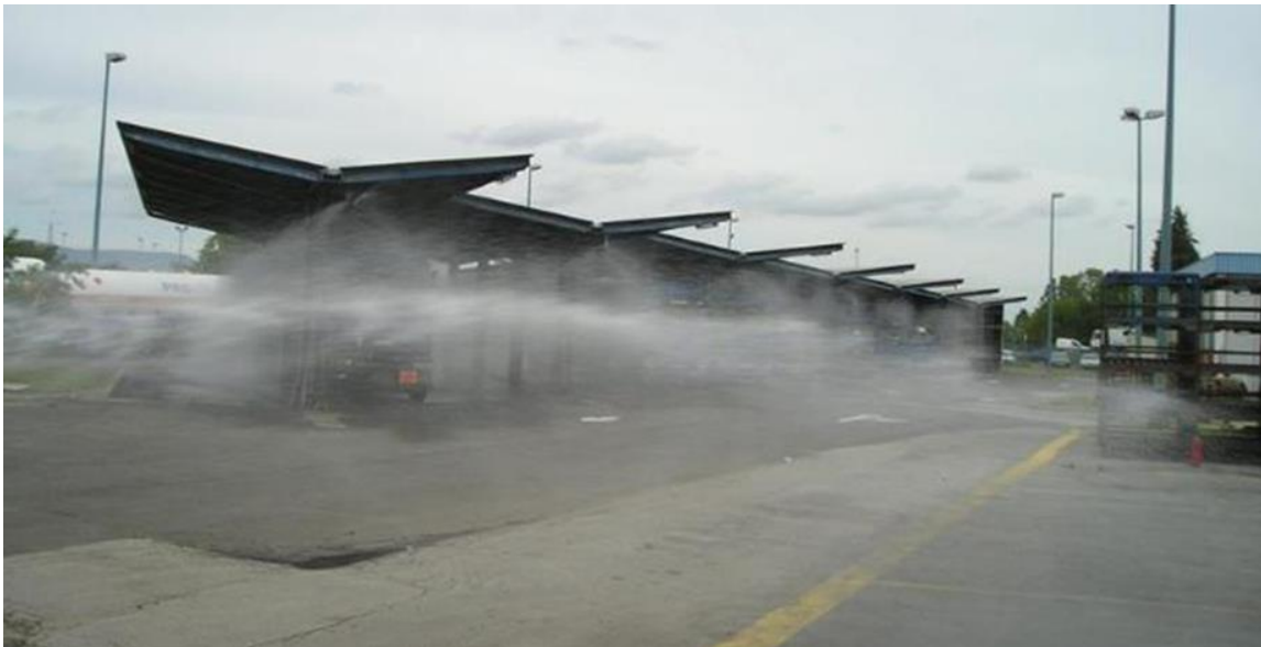
Slika 15. Vježba gašenja i kontrola sustava za gašenje AC [2]
