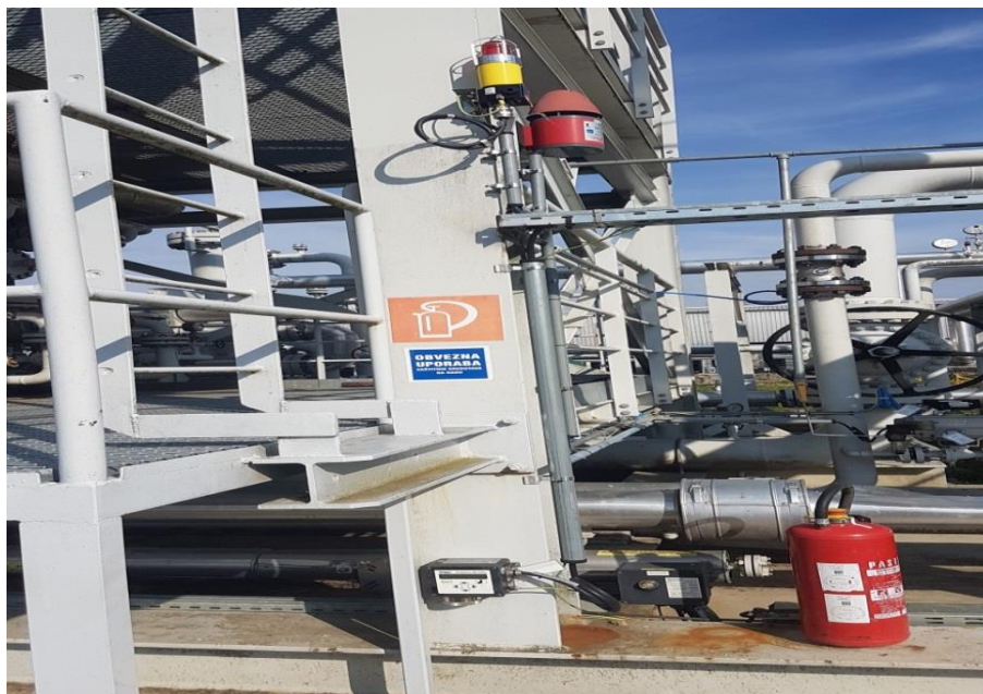
Slika 34. Stabilni detektor CO 2
