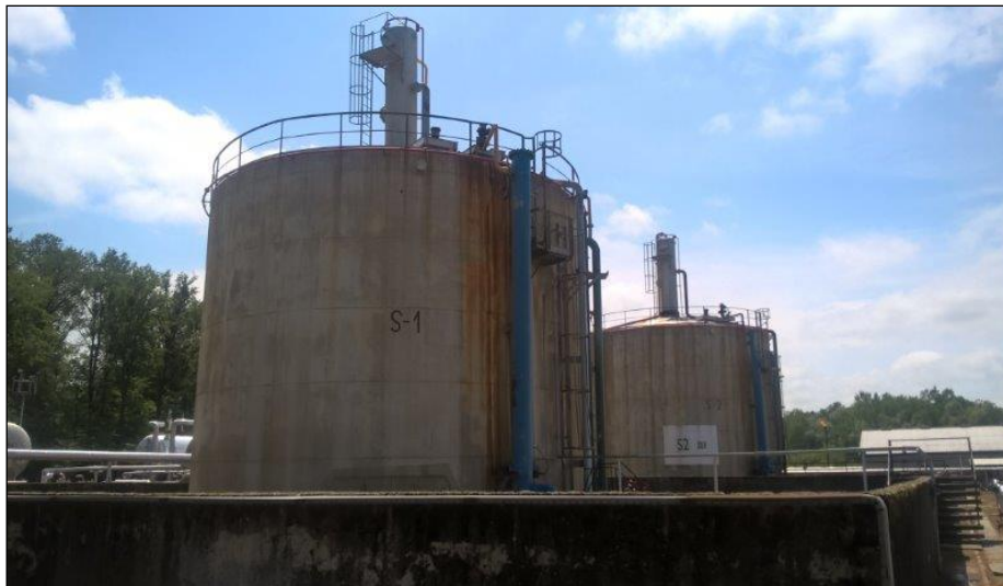
Slika 6. Dekantator S-1 [2]
