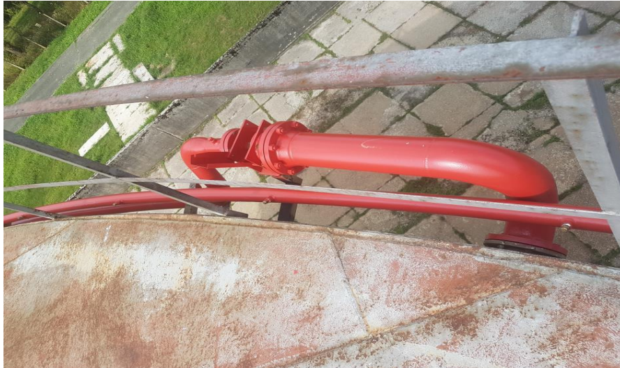
Slika 43. Zračna komora za spremnik sa čvrstim krovom (R-5)
