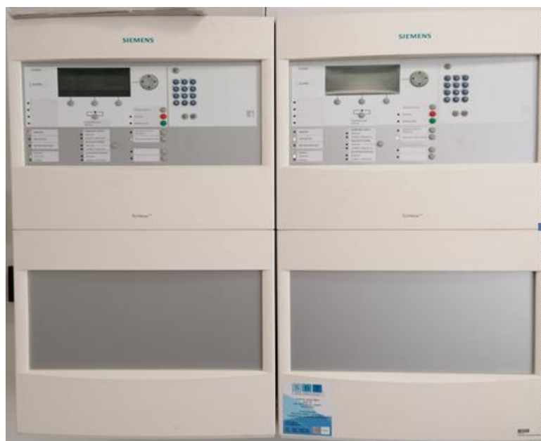
Sl. 15. Vatrodojavna centrala Siemens Sinteso FC2060 [24]
