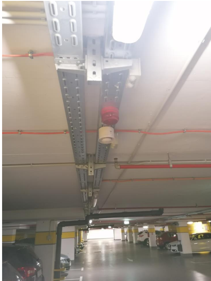
Sl. 17. Zvučna i svjetlosna signalizacija [24]
