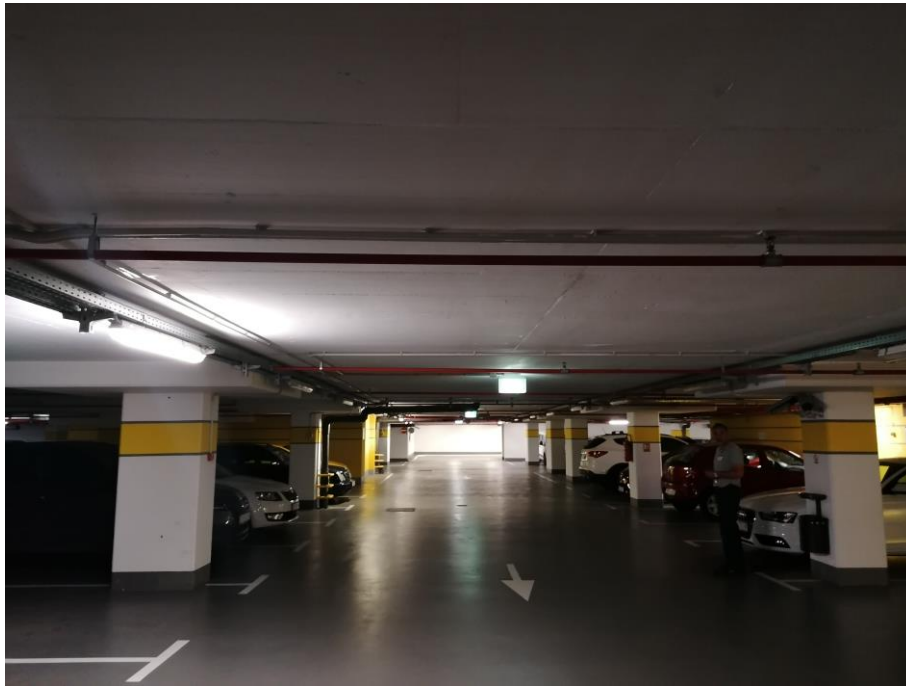
Sl. 22. Podzemna garaža [24]
