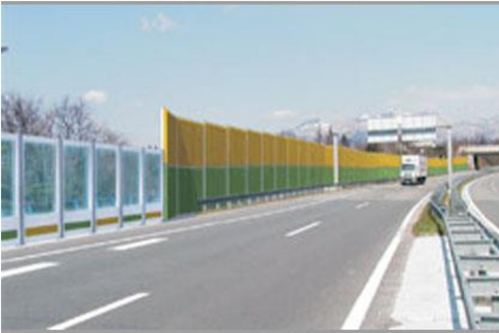
Slika 7. 2. Zidovi za zaštitu od buke
