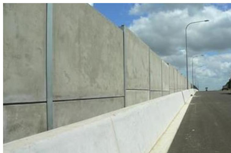
Slika 7. 7. Armirano-betonski paneli
