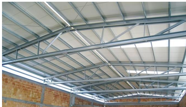
Slika 1.3. Krovni nosač [3]
