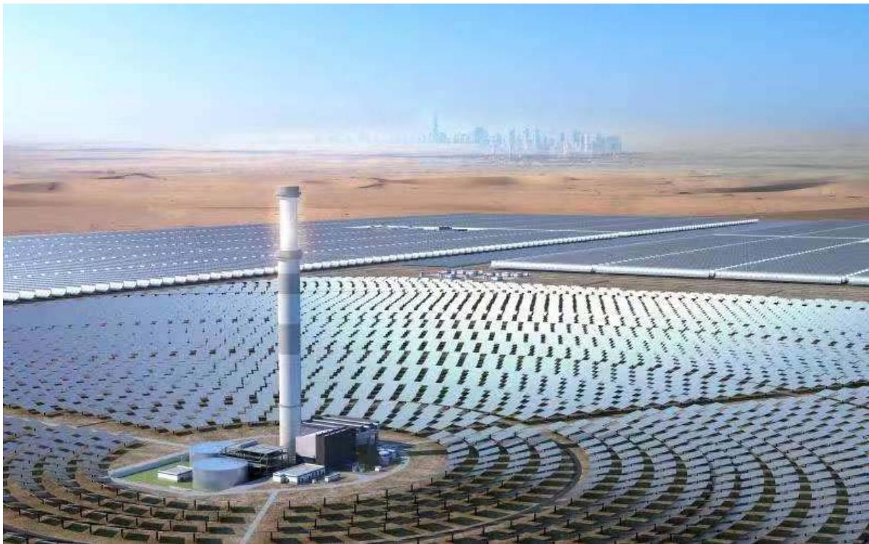
Slika 10. Primjer elektrane sa sunčevim tornjem (Ujedinjeni Emirati, snaga 600MW) [7]
