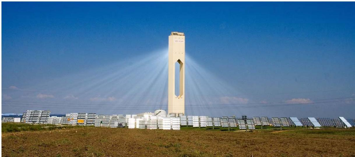
Slika 5. Solarni koncentrirani sustav sa tornjem [3]
