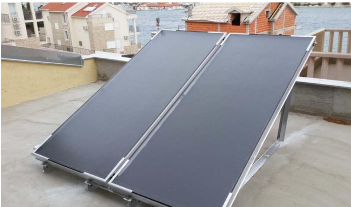
Slika 21. Pločasti solarni kolektori (instalacija na krovu obiteljske kuće) [autor]
