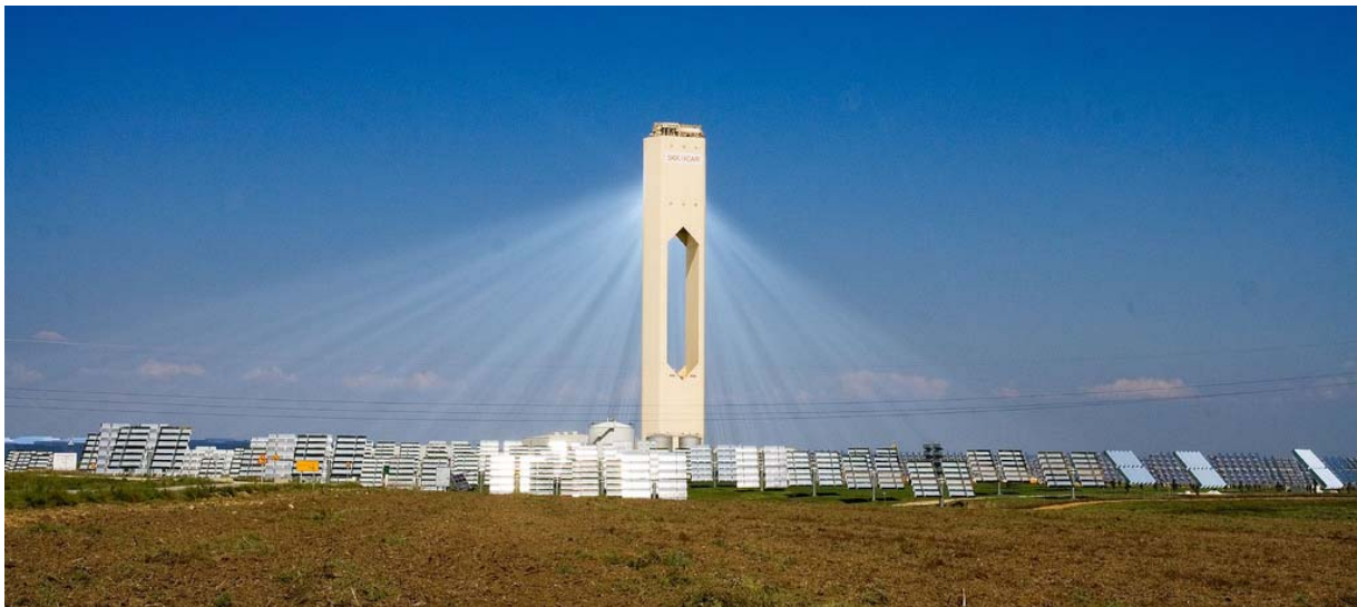
Slika 5. Solarni koncentrirani sustav sa tornjem [3]
