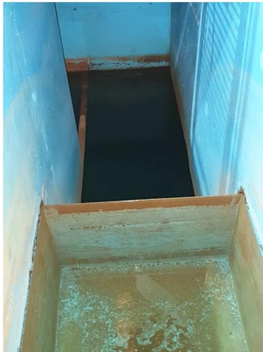
Slika 15. Ploča (nož) preljeva [i.a.]
