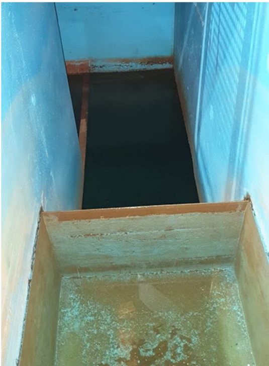
Slika 15. Ploča (nož) preljeva [i.a.]
