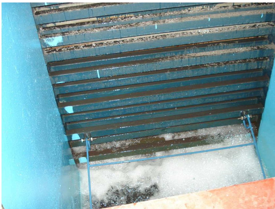
Slika 18. Umirivač protoka [i.a.]
