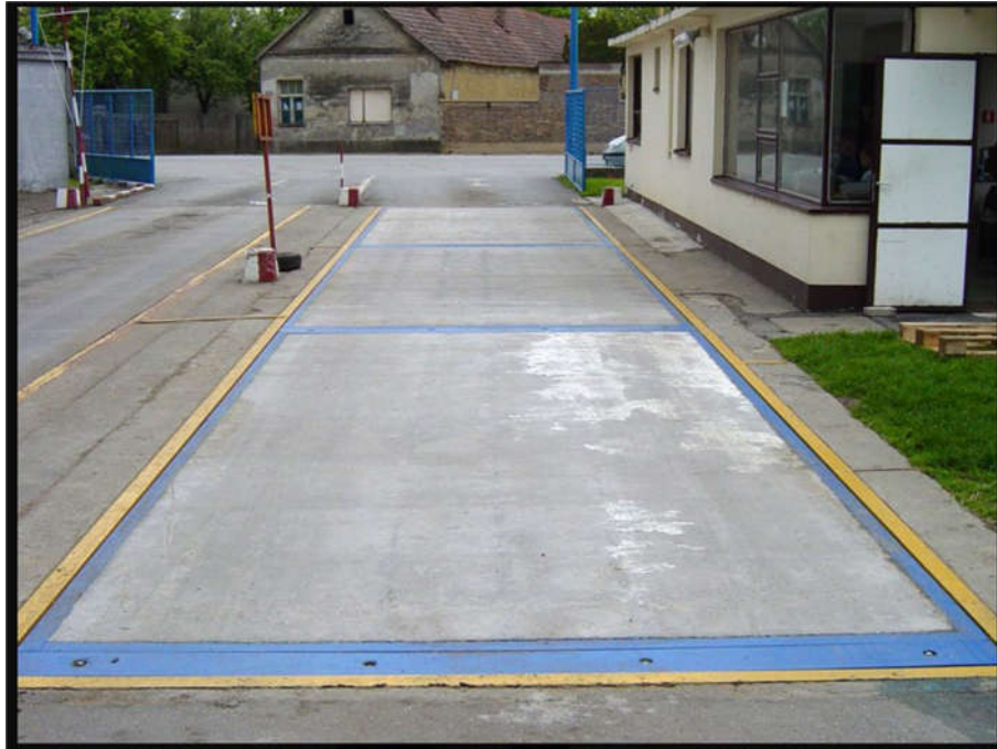
Slika 6. Kolna vaga za kamione 44
