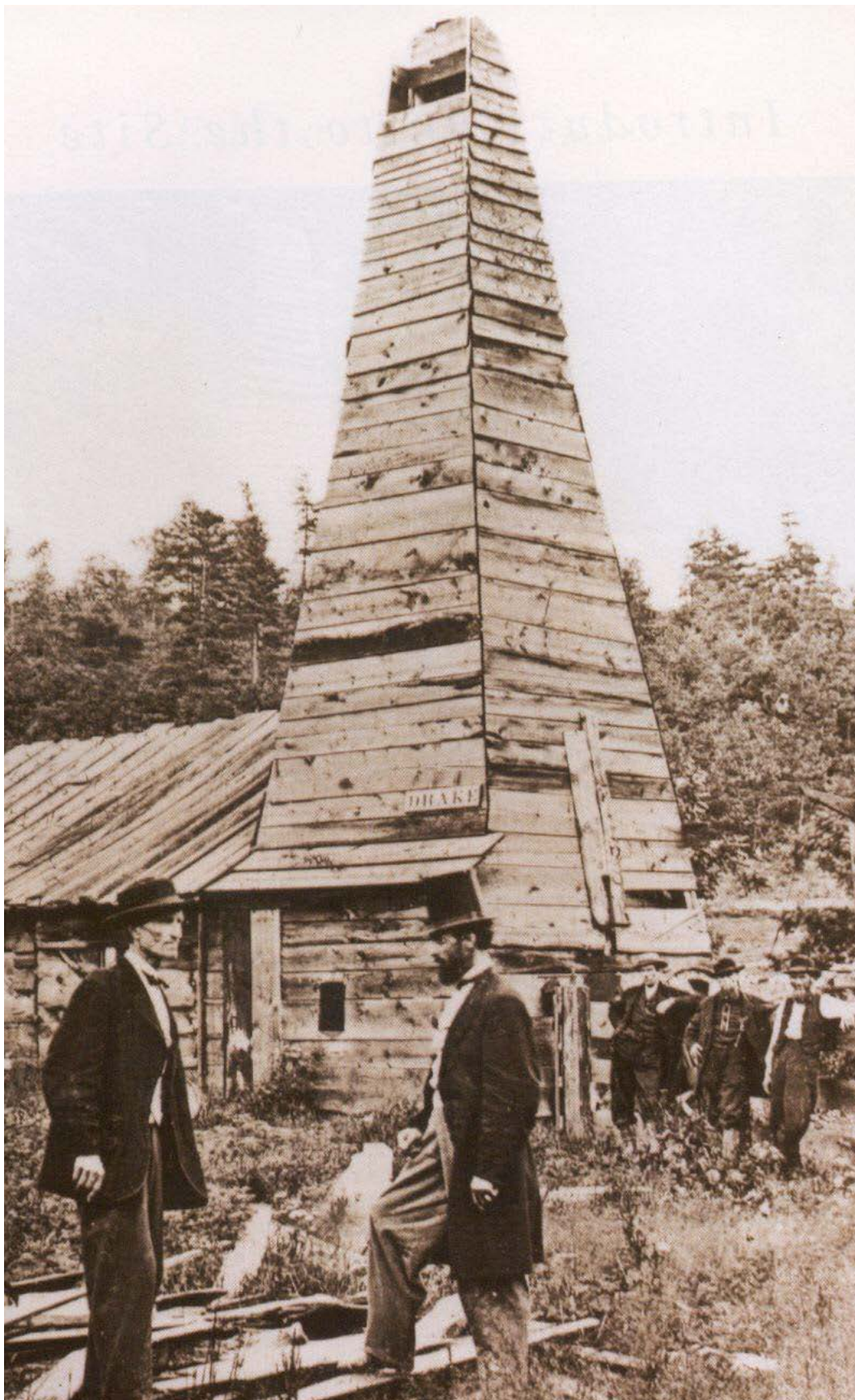
Slika 1. Toranj za bušenje Edwina L. Drakea, 1859. godina
