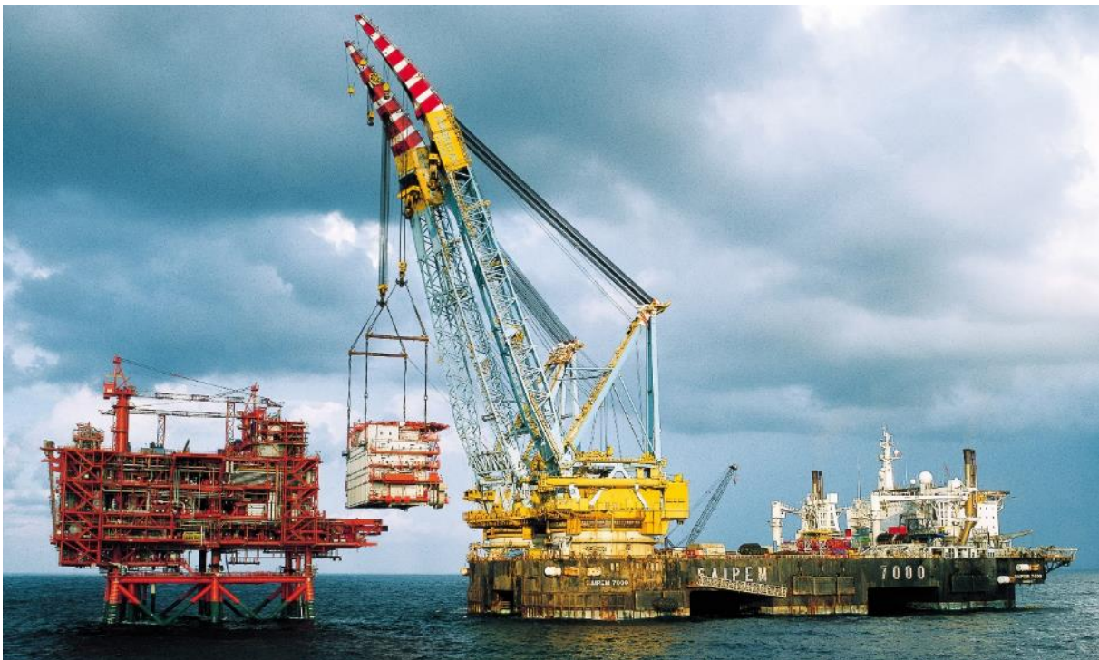
Slika 16. Saipem 7000 i zadizanje stambenog bloka u Libiji
