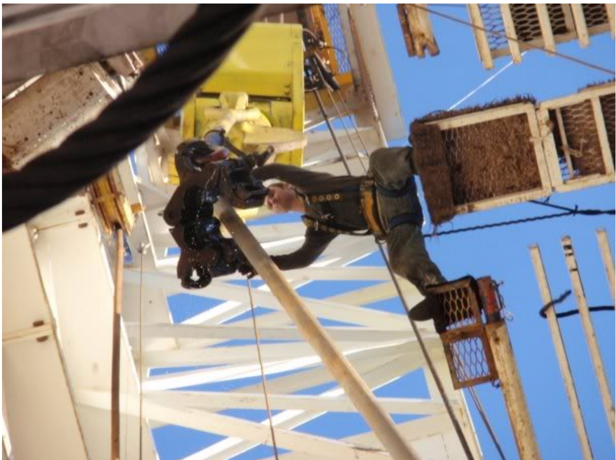
Slika 40. Tornjaš ubacuje šipku u elevator
