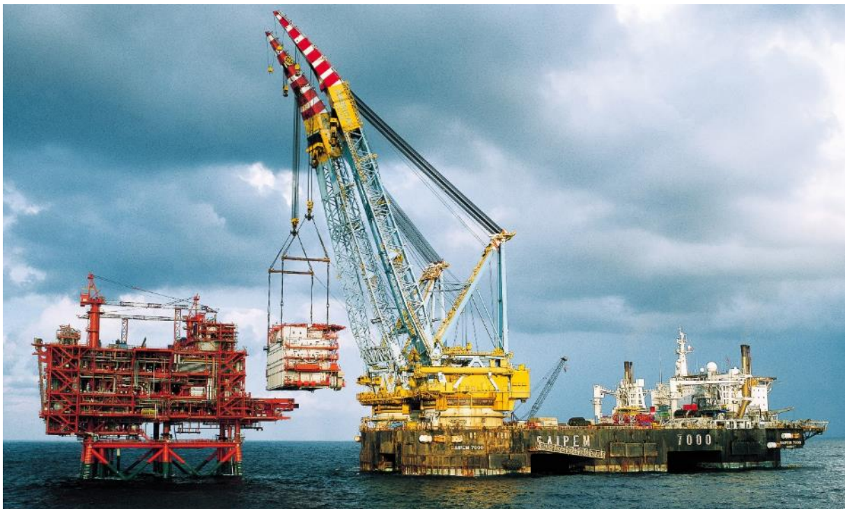
Slika 16. Saipem 7000 i zadizanje stambenog bloka u Libiji
