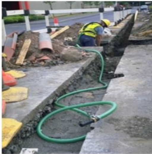
Slika 19 Cijevni uređaj sa svježim zrakom
