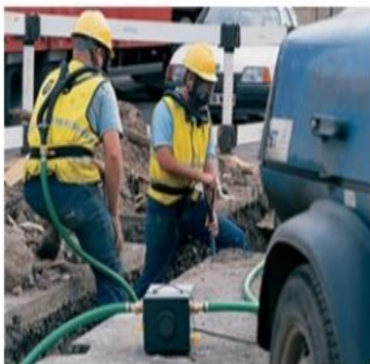
Slika 20 Cijevni uređaj s dovodom čistog zraka pomoću puhala ili mijeha
