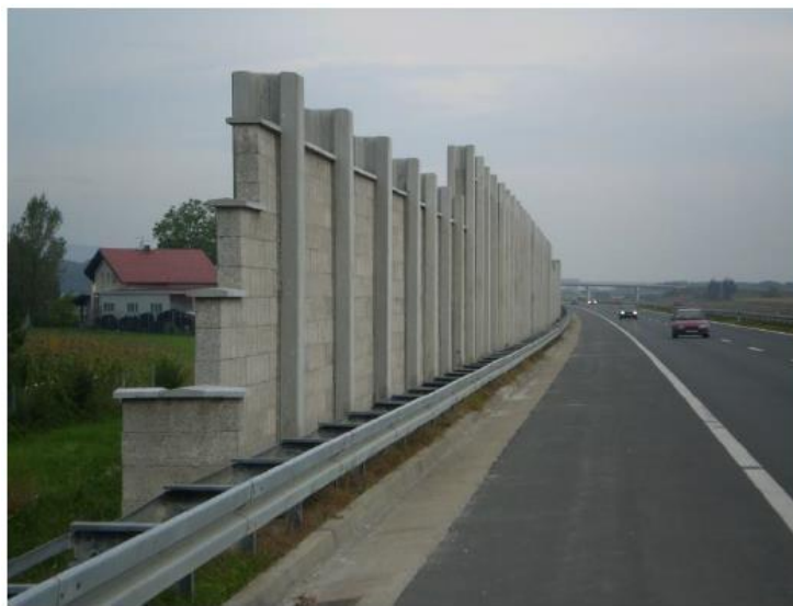
Slika 15. Zidovi za zaštitu od buke
