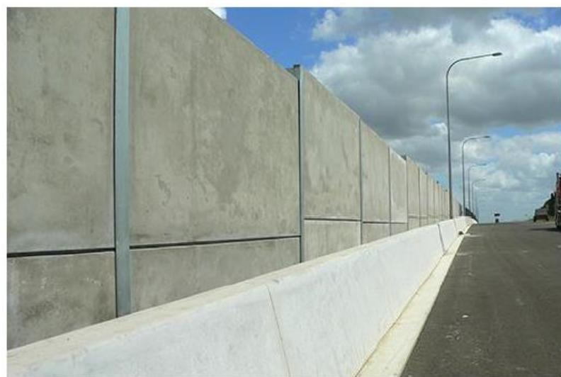
Slika 20. Armirano-betonски paneli
