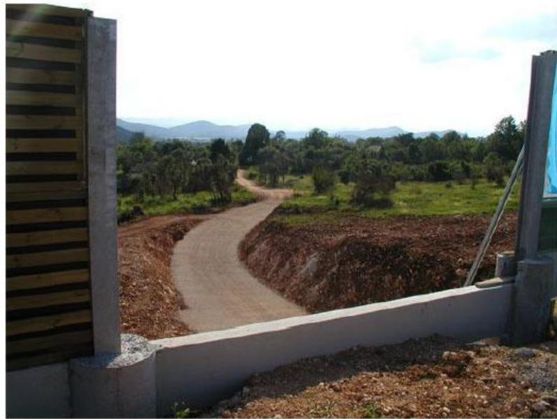
Slika 23. Čelični profil i temelji profila sa mogućnošću jednostavnog umetanja nosive grede
