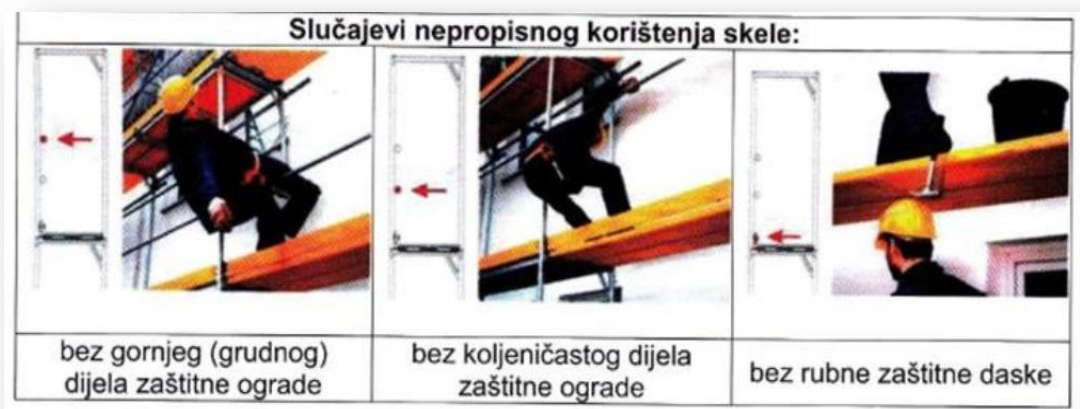
Slika 3 Korištenje skele na zidarskim radovima
