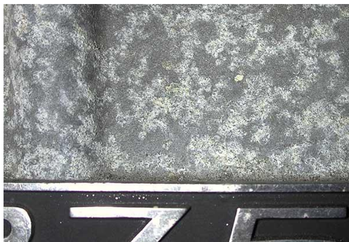
Slika 2. Jednolika korozija aluminija
