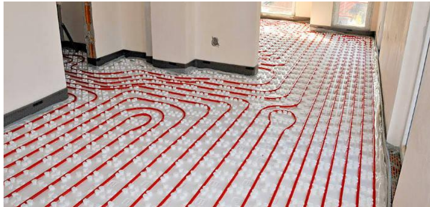
Slika 11. Primjer podnog grijanja [7]
