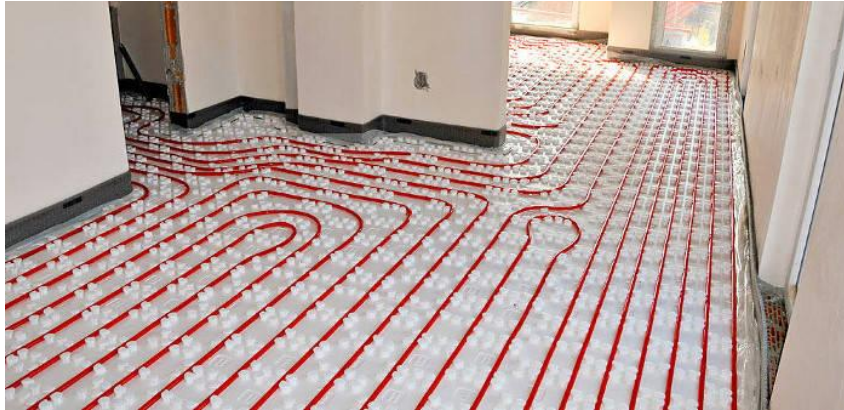
Slika 11. Primjer podnog grijanja [7]
