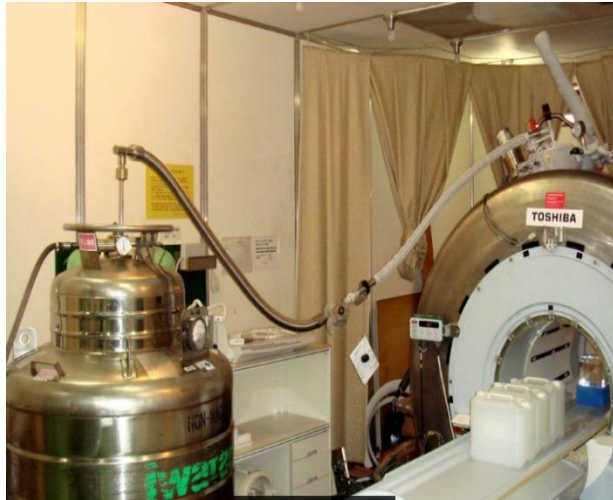
Slika 17. Predodžba pretakanja tekućeg helija. Izvorno autor
