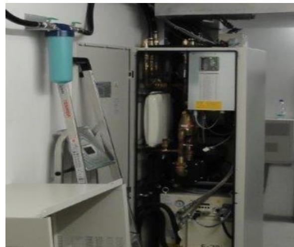
Slika 11. Predodžba voda - voda sustava s kompresorom. Izvorno autor.
