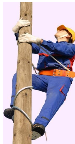
Slika 9. Prikaz penjalica i njihove uporabe na drvenim stupovima
