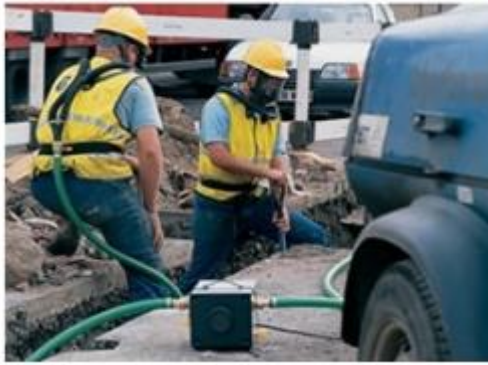
Slika 26: Cijevni uređaji s dovodom čistog zraka pomoću puhala ili mijeha [1]
