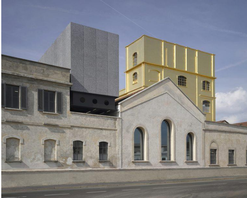
Slika 48. Objekt izrađen od fasadnih obloga od Al metalne pjene [15]
