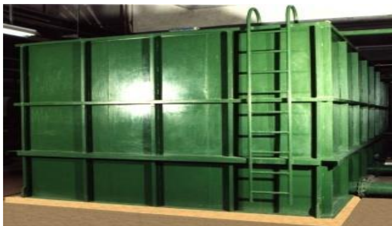
Sl. 5. Preljevni akumulacijski spremnik [13]
