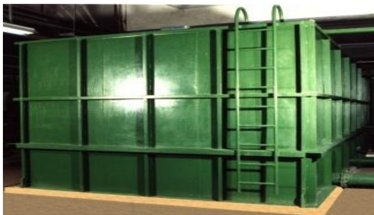
Sl. 5. Preljevni akumulacijski spremnik [13]
