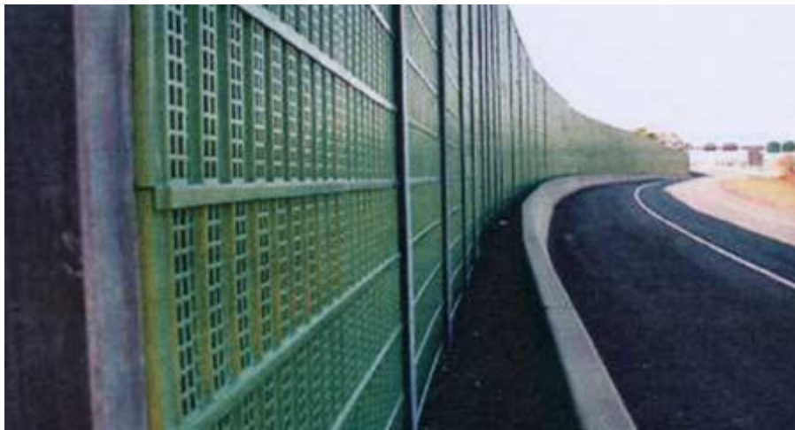
Slika 7. Barijere za zaštitu od prometne buke
