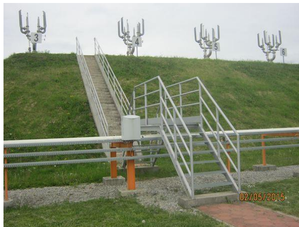
Slika 4. Spremnici terminala s brojevima spremnika
