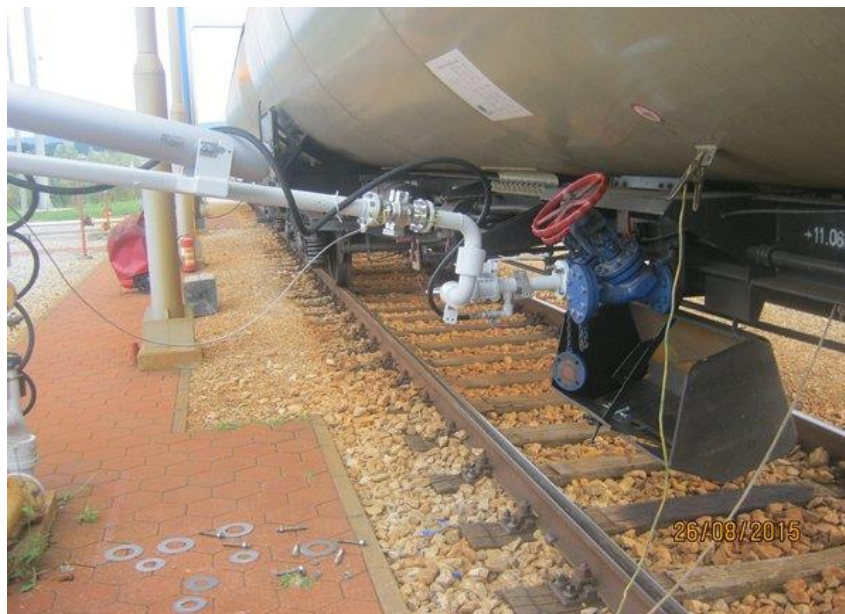
Slika 33. Spojena istakačka ruka na vagon cisternu
